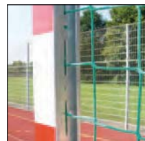
Torrahmen mit eingefrästen Netzhaken.
