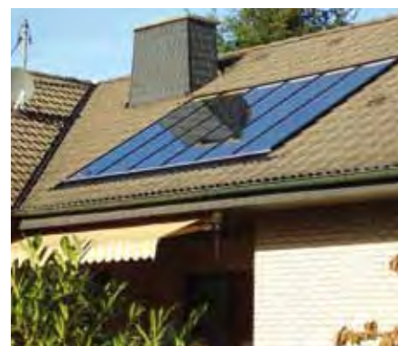
Panneaux solaires pré-assemblés. Installation en sur-toiture (GFK A), intégration en toiture (GFK I)
