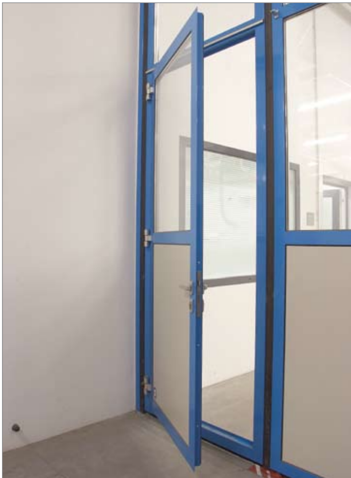
Gehtür im Torflügel eingebaut pedestrian door built in one section
