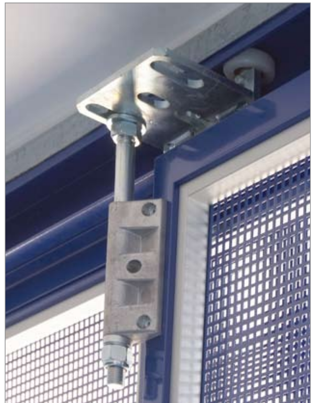
STT - Aufhängung STT – suspension at the top
