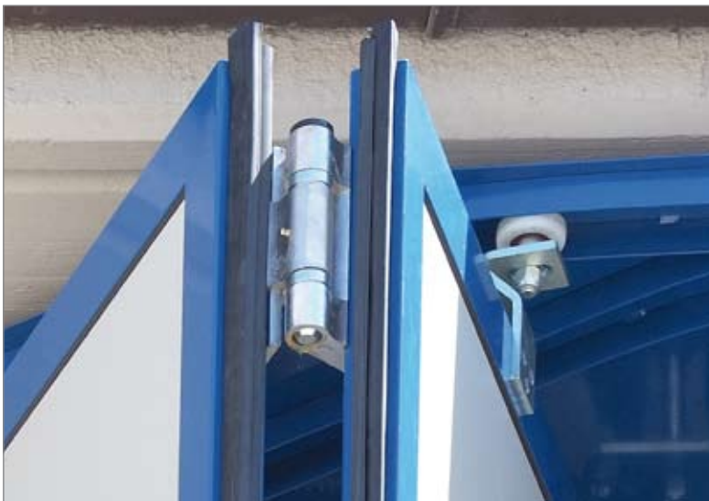
Scharnier und Umlenkrolle Hinge and deflection roller
